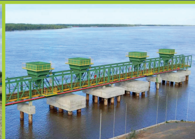
Transporte de Sólidos a Granel y Grandes Estructuras Metálicas
